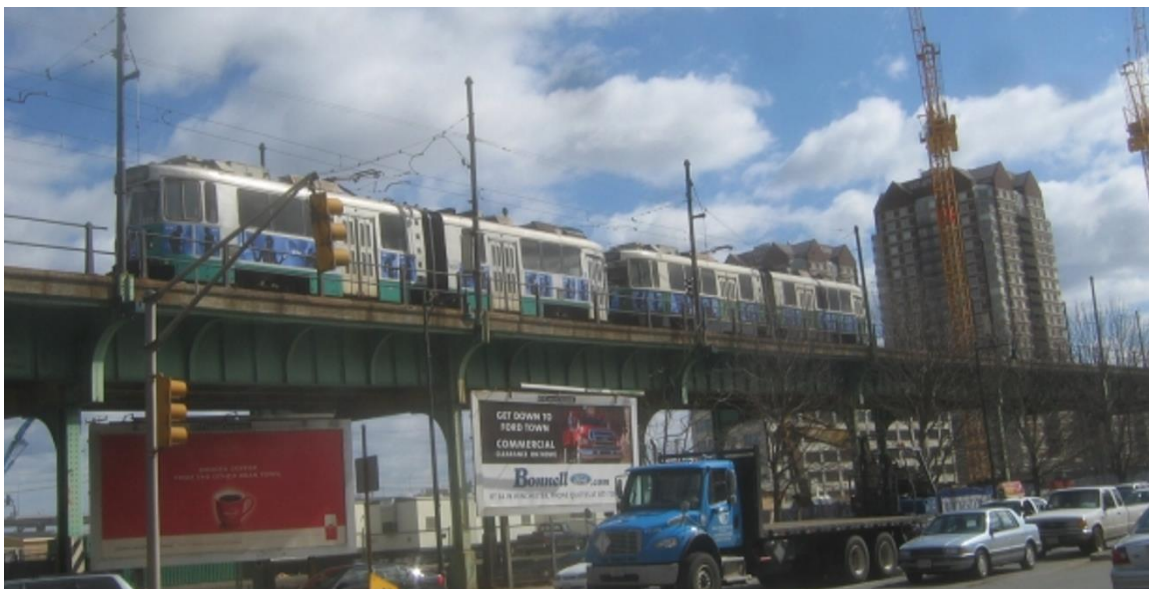
Abbildung 1. – Eisenbahnüberführung in Cambridge, USA
