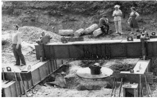
Рисунок 2 – Загальний вигляд стенда для дослідження процесу занурення конічних блоків у ґрунт в натурних умовах
