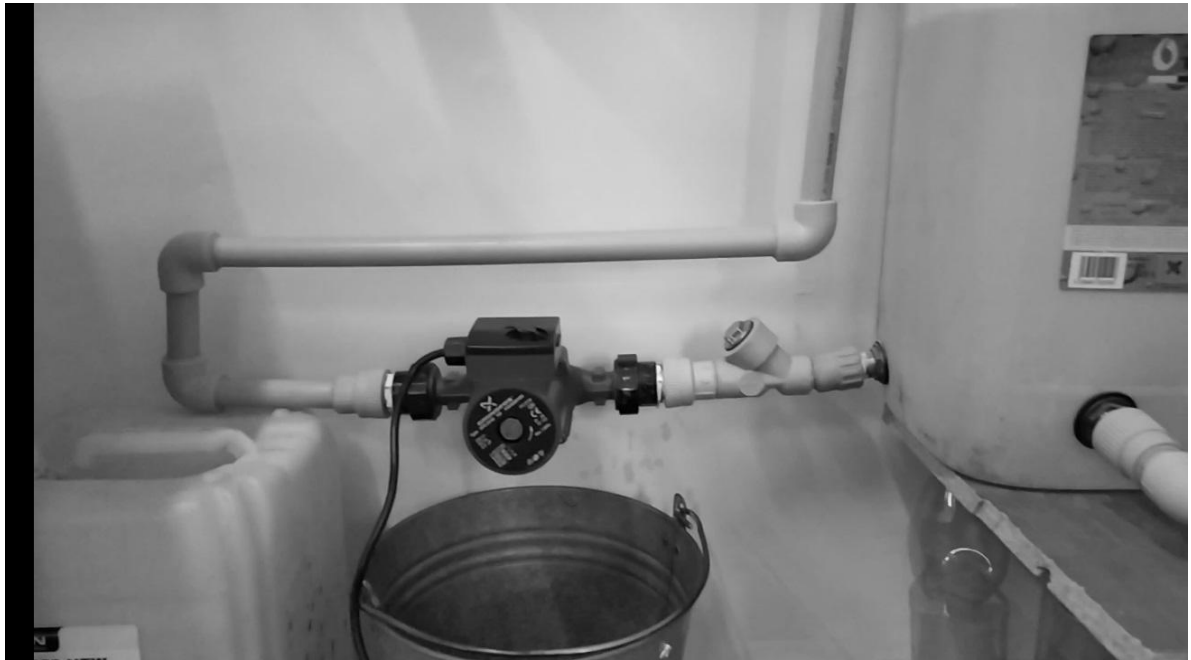
Рисунок 4.4 – Циркуляційний насос
