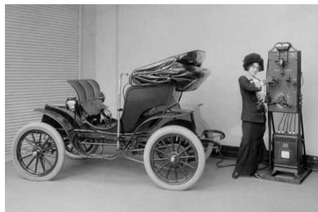
Зарядна станція електромобілів
