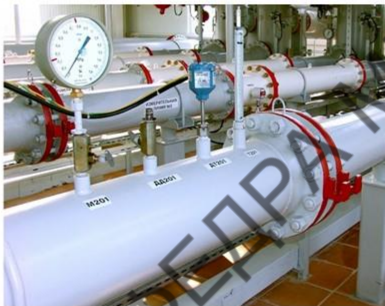
Рисунок 6 – Приклад багатоканального вимірювального каналу тиску
