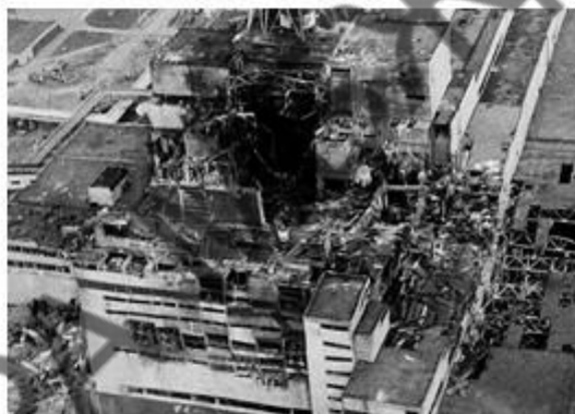
Рисунок 5 – Зруйнований четвертий енергоблок Чорнобильської атомної електростанції
